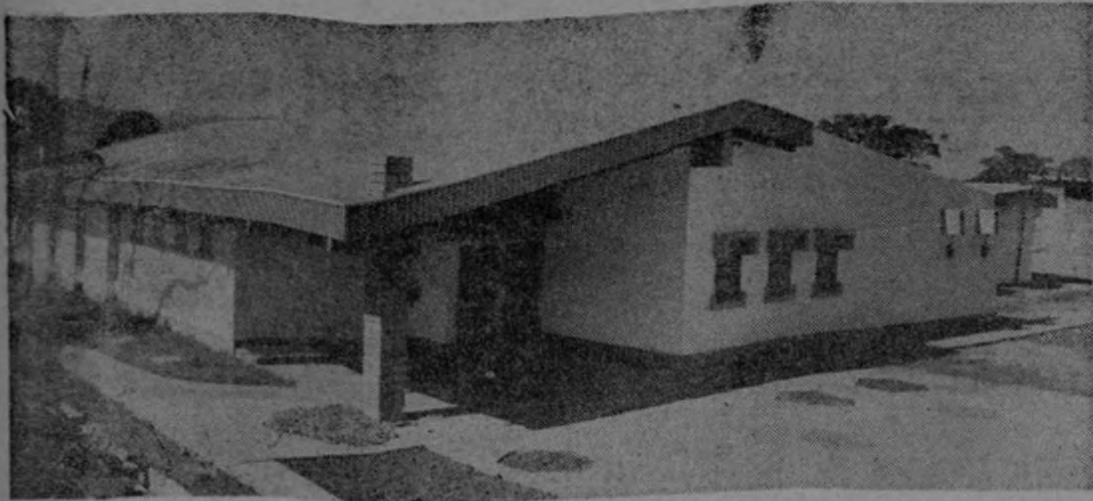
Vista general Edificio Administración.
