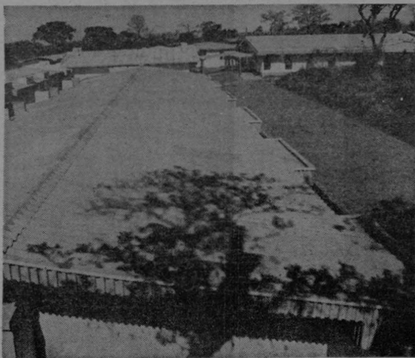
Cubierta de RICALIT, de uno de los 6 pabellones.
